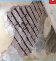
石屎剝落 / 鋼筋外露
