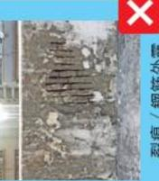
裂痕 / 鋼筋外露
